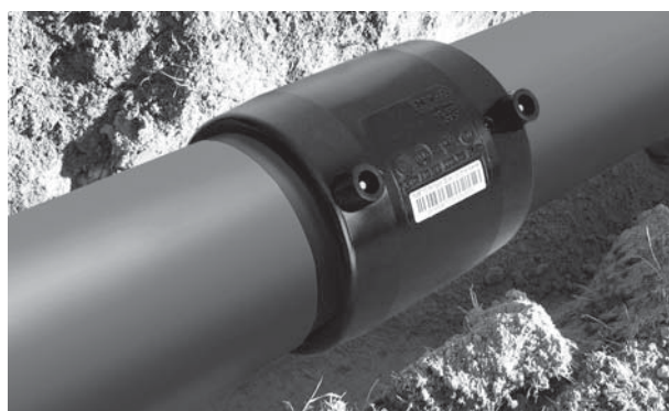
Рис. 5.2. Соединение муфтой с закладным нагревательным элементом
