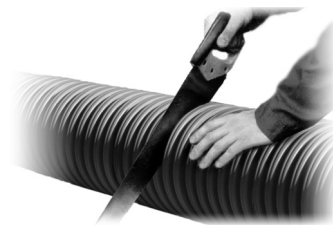
Рис. 1.4. Резка ПП гофрированных труб
