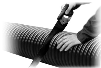
Рис. 1.4. Резка ПП гофрированных труб
