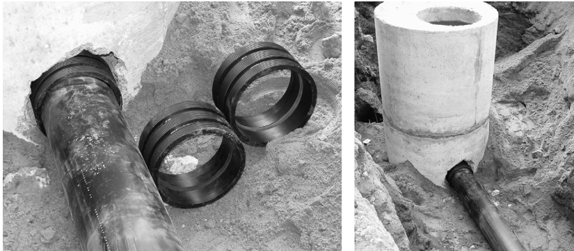
Фото 2.1. Защитные муфты для входа в бетонный колодец
