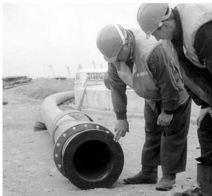
Фото 1.4. Разъемное фланцевое соединение ПЭ труб
